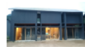
▲アーカイブ棟 映像のデジタル化・変換・メディア保管を行う。 1階：作業スペース 2階：保管庫
